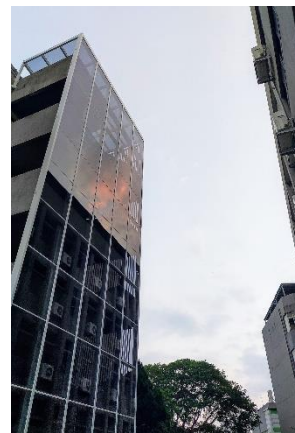
108 學年度 側梯遮雨玻璃帷幕 完成圖
